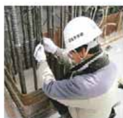
鉄筋継手部検査
